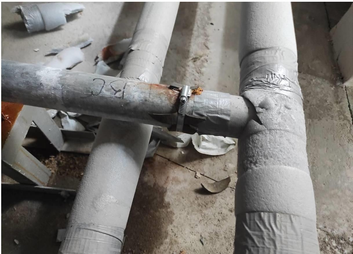
**Фото 14.** Место ремонта разрыва трубы ГВС на техэтаже. Коррозия трубопровода. Частичное отсутствие теплоизоляции
