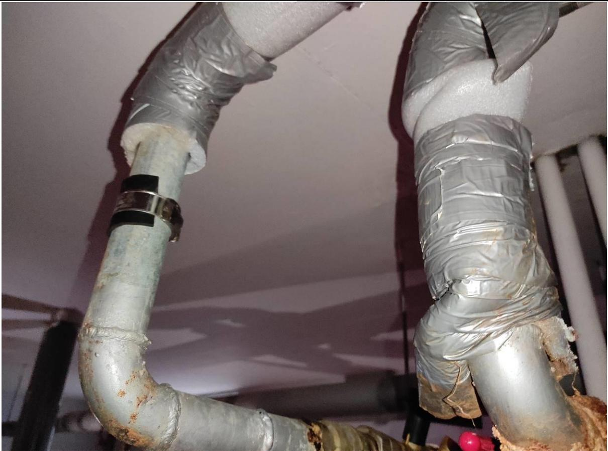
**Фото 7.** Сварные соединения оцинкованных труб. Коррозия трубопроводов, мест соединения с запорной арматурой. Некачественно выполненная теплоизоляция
