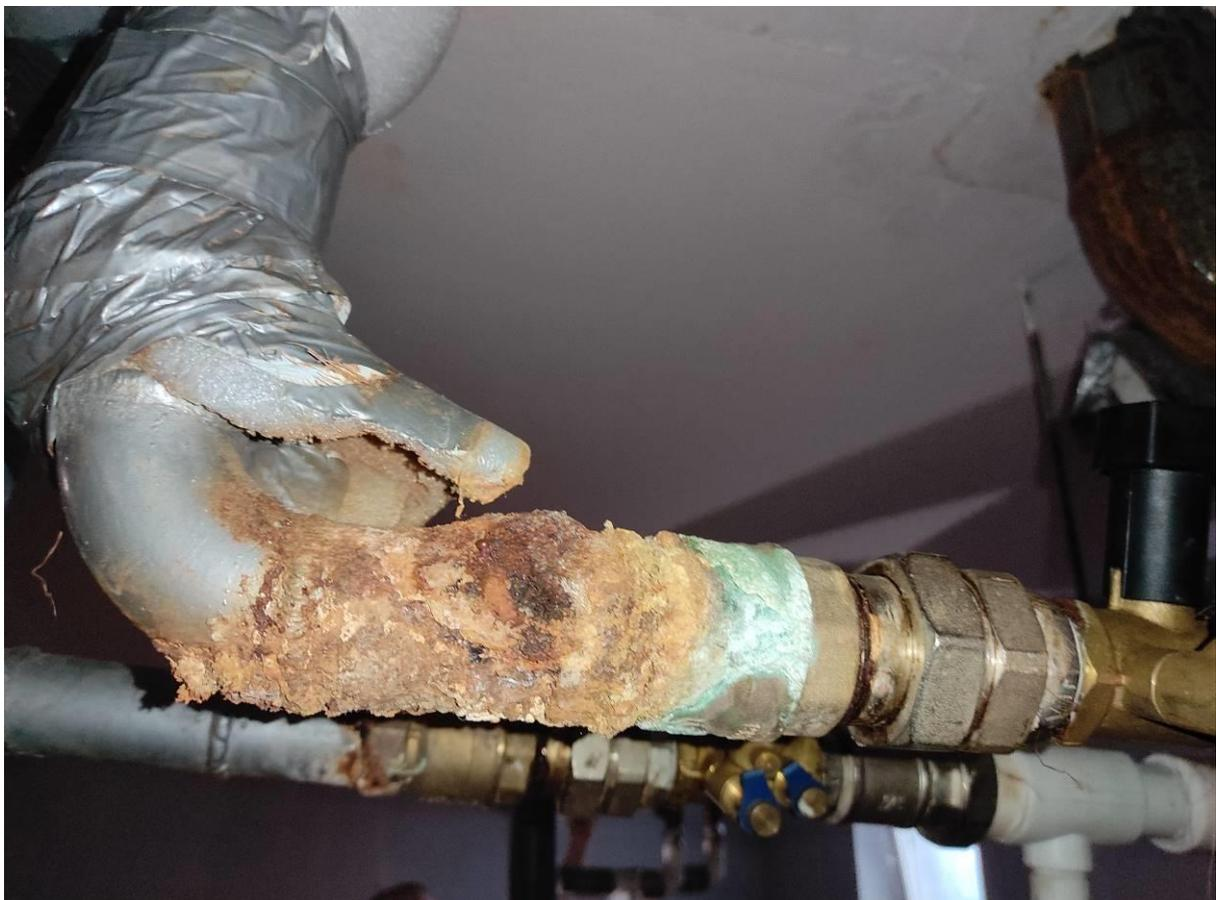
**Фото 8.** Разрыв, коррозия трубопроводов, коррозия мест соединения трубопроводов с запорной арматурой. Частичное отсутствие теплоизоляции на трубопроводах
