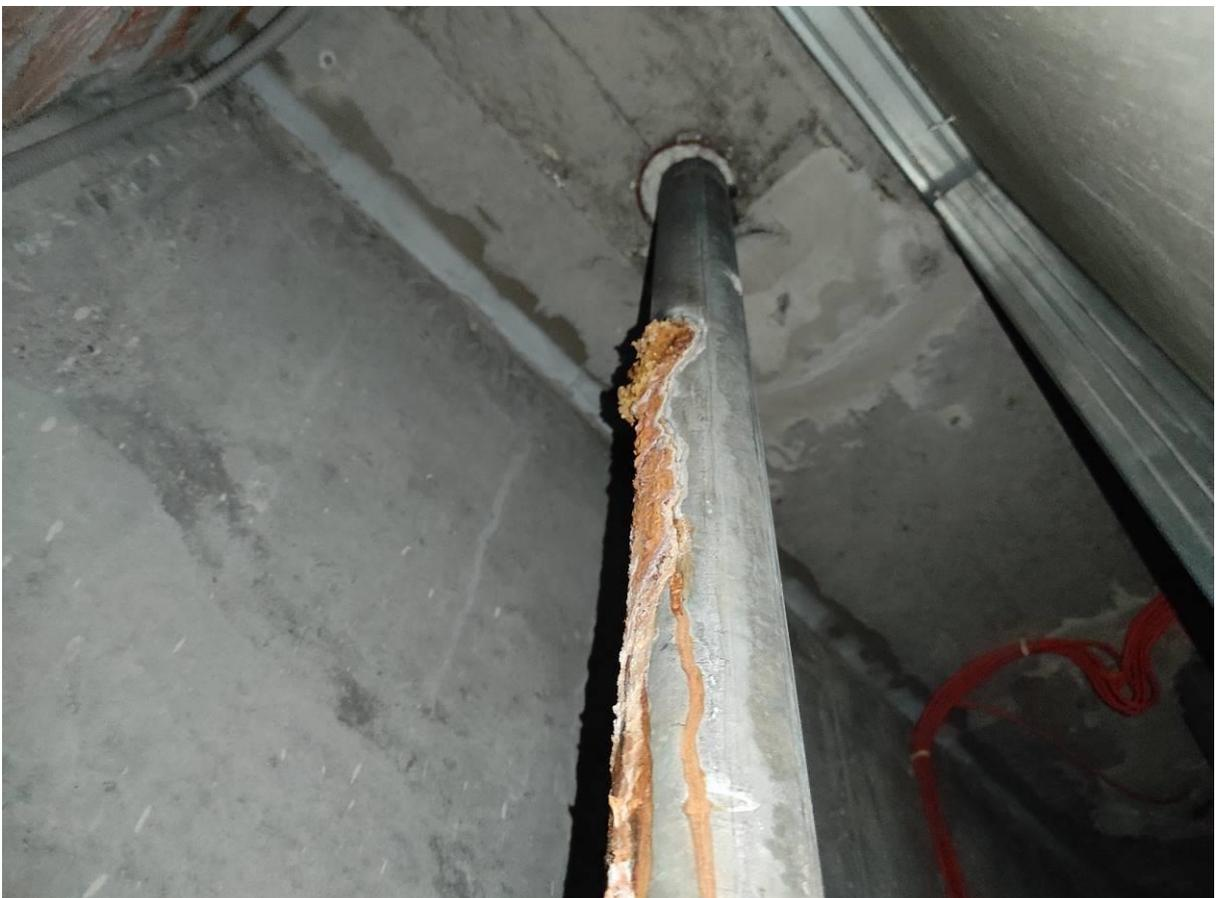
**Фото 18.** Разрыв трубопровода ГВС на 13 этаже. Коррозия трубопровода. Отсутствие теплоизоляции
