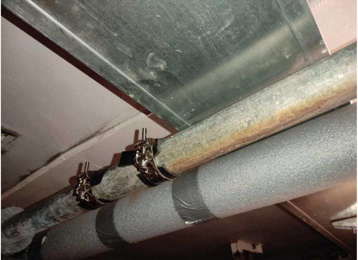
**Фото 3.** Отсутствие теплоизоляции на обратном трубопроводе. Участки ремонта трубопровода. Коррозия трубы обратного трубопровода
