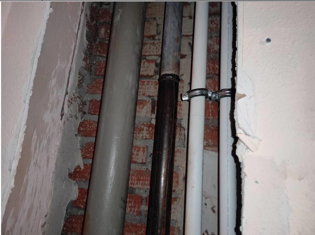
**Фото 9.** Сварное соединение главного стояка ТЗ (8 этаж). Вставка из черной (неоцинкованной) трубы. Коррозия стояка ТЗ. Отсутствие теплоизоляции стояков водоснабжения
