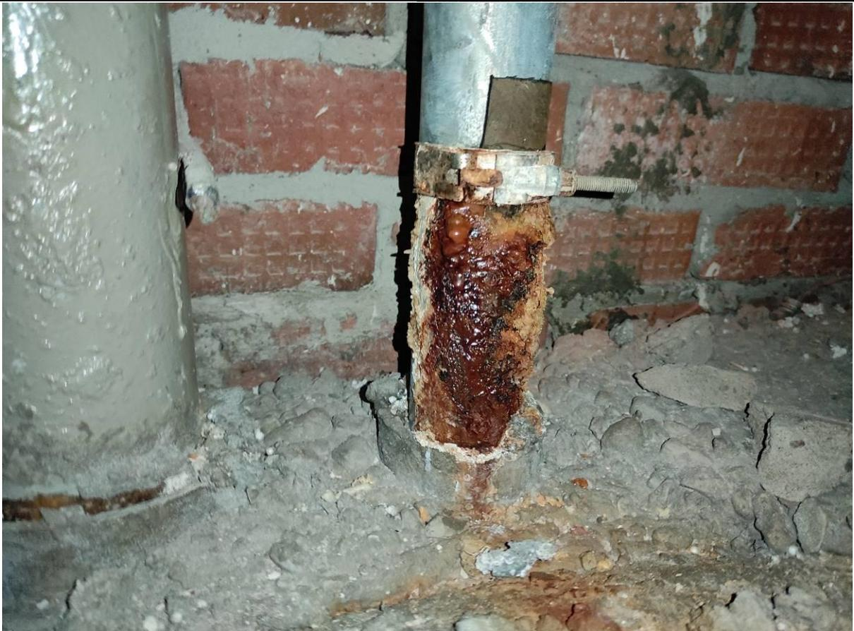
**Фото 19.** Место ремонта разрыва трубопровода ГВС на 19 этаже. Коррозия трубопровода.
