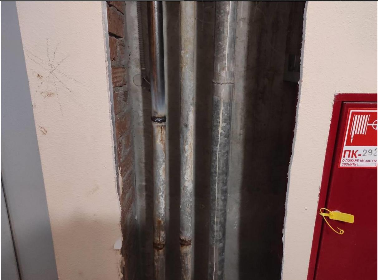
**Фото 13.** Сварные соединения оцинкованных труб. Коррозия трубопроводов. Большое количество вставок труб разной длины. Отсутствие теплоизоляции трубопроводов (7 этаж)
