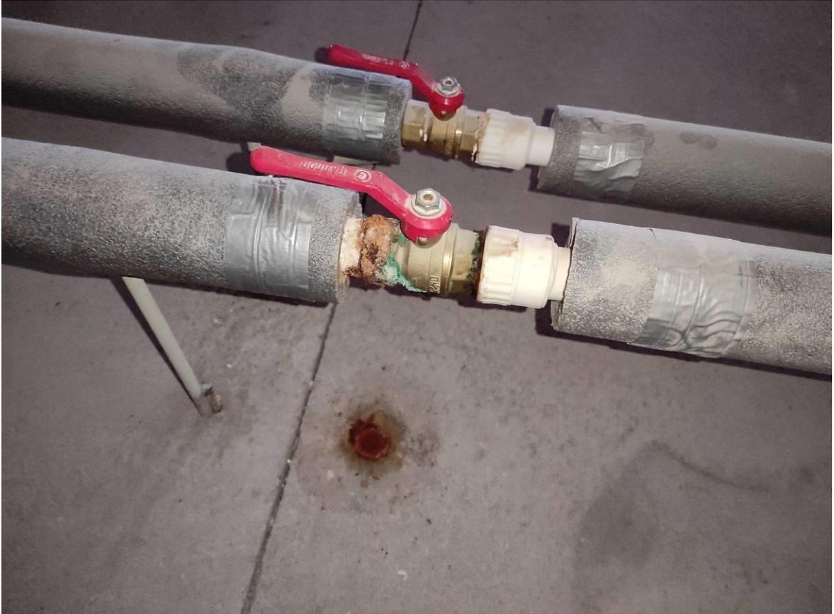
**Фото 15.** Негерметичное резьбовое соединение запорной арматуры и трубопровода. Следы протечек, коррозия
