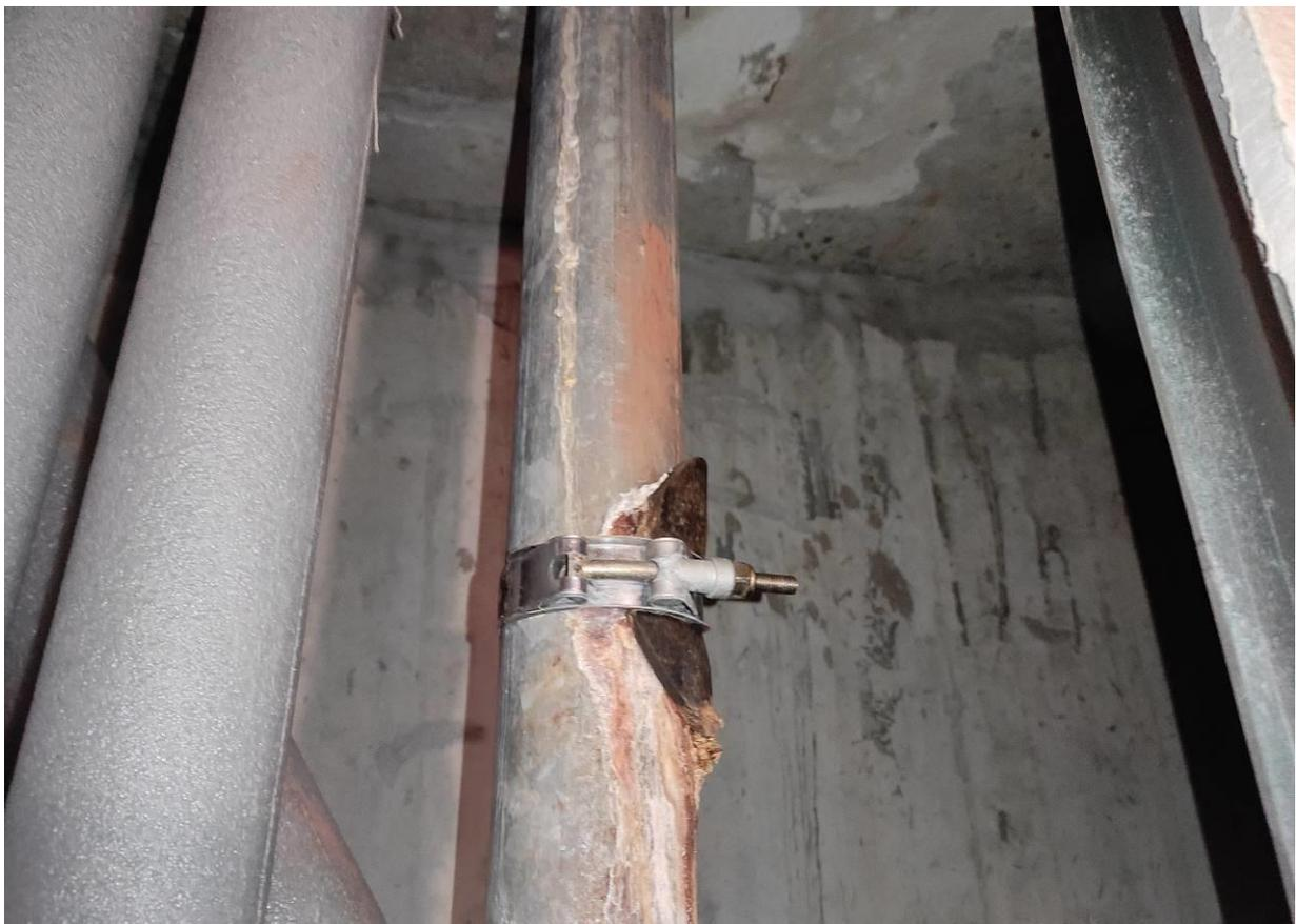
**Фото 16.** Место ремонта разрыва трубы ГВС на 3 этаже. Коррозия трубопровода. Отсутствие теплоизоляции
