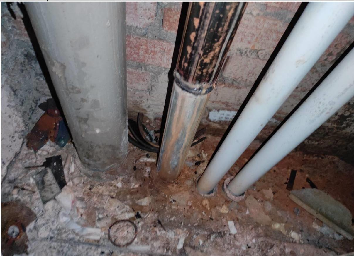
**Фото 11.** Сварное соединение главного стояка Т3 (8 этаж). Вставка из черной (неоцинкованной) трубы. Коррозия стояка Т3. Отсутствие теплоизоляции стояков водоснабжения
