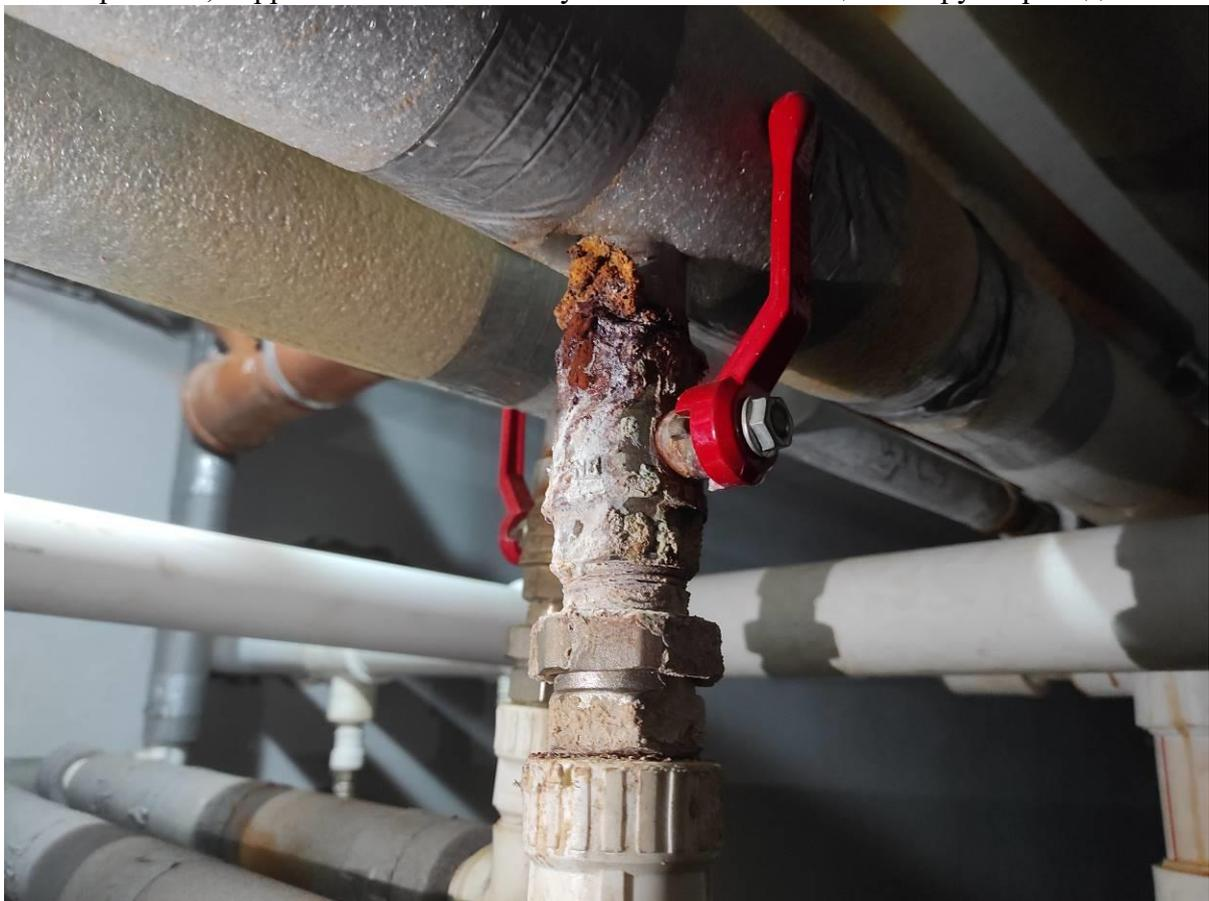
**Фото 6.** Негерметичное резьбовое соединение запорной арматуры и трубопровода. Следы протечек, коррозия
