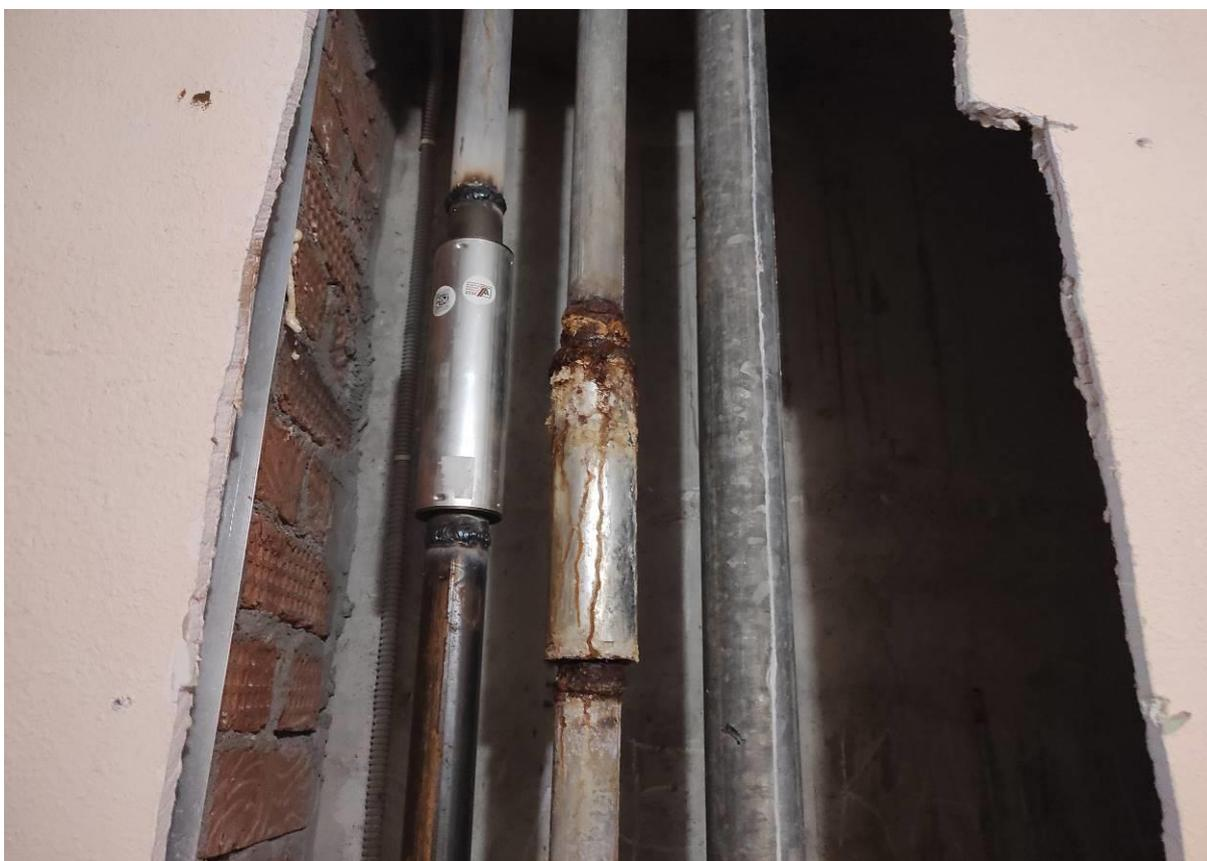
**Фото 12.** Сварные соединения обратных трубопроводов Т4 (н.з.), Т4 (в.з.) с компенсаторами (7 этаж). Коррозия трубопроводов и компенсатора. Участок трубопровода Т4 выполнен из черной (неоцинкованной) трубы. Отсутствие теплоизоляции трубопроводов
