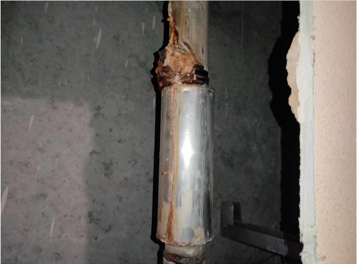
**Фото 17.** Сварное соединение подающего трубопровода ТЗ с компенсатором (13 этаж).
