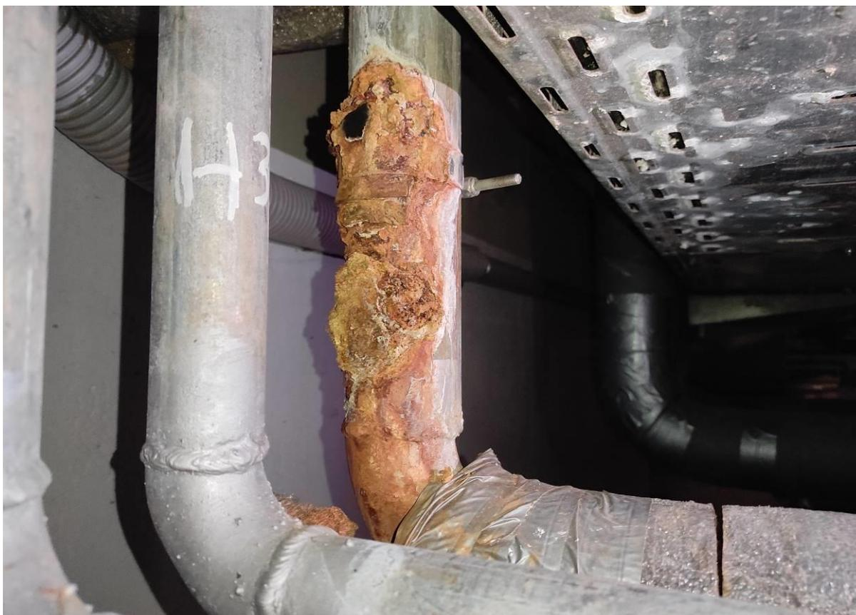
**Фото 2.** Сварные соединения оцинкованных труб. Разрыв подающего трубопровода. Коррозия трубопровода Т3. Частичное отсутствие теплоизоляции на трубопроводах
