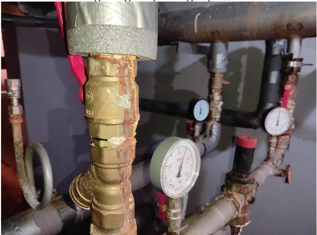
**Фото 4.** Негерметичное резьбовое соединение запорной арматуры и трубопровода. Следы протечек, коррозия. Частичное отсутствие теплоизоляции на трубопроводах
